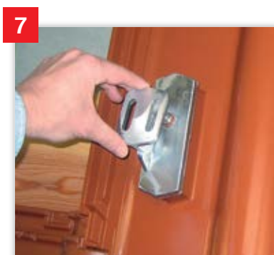
7 Anschließend den montierten Solarträgeraufsatz nach Dachneigung ausrichten.
