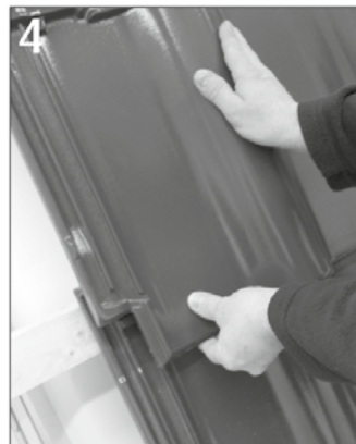
4 Den Dachziegel eindecken und andrücken. Fertig!
