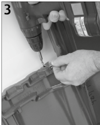
3 und von oben in die Traglattung einschrauben.
