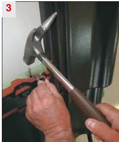
3 ... und von oben in die Traglattung einschlagen.
