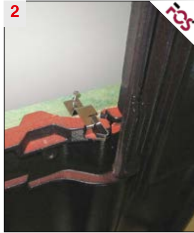
2 ... an der vorgesehenen Vertiefung positionieren...
