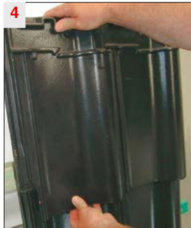
4 Dachziegel eindecken und andrücken. Fertig!
