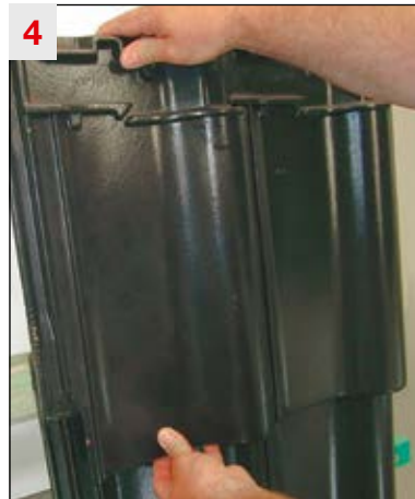
4 Dachziegel eindecken und andrücken. Fertig!
