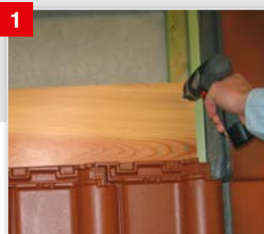
1 Holzbohle in Stärke der Traglatte (ca. 160 mm breit) direkt oberhalb der Dachziegel in die Tragkonstruktion befestigen.
