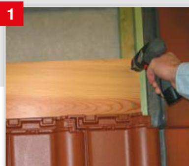
1 Holzbohle in Stärke der Traglatte (ca. 160 mm breit) direkt oberhalb der Dachziegel in die Tragkonstruktion befestigen.
