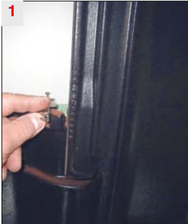
1 Multi-Sturmkralle über den Kopffalz...
