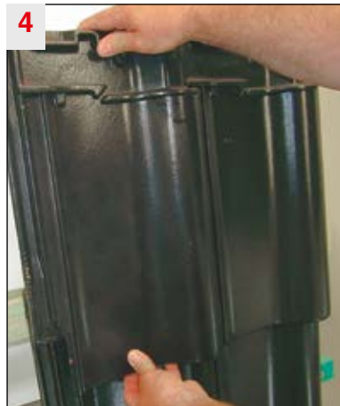
4 Dachziegel eindecken und andrücken. Fertig!
