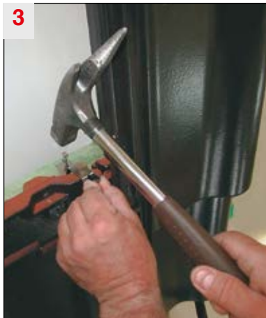
3 ... und von oben in die Traglattung einschlagen.
